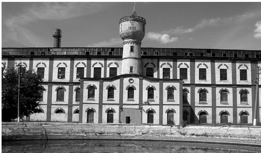
Ил. 1. Здание бывшего сахарного завода. Фотография автора
