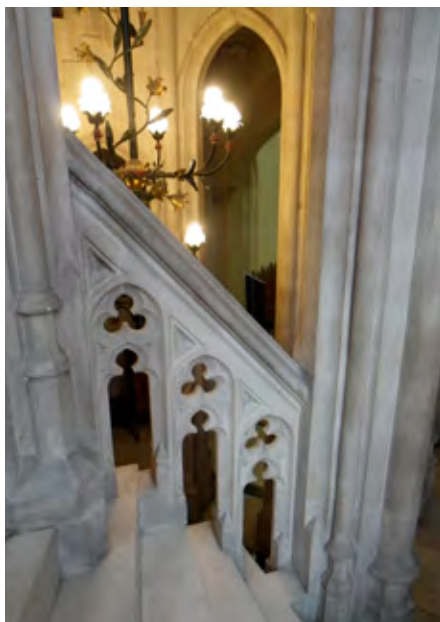
Ил. 22. Лестница в здании Муниципалитета в Брюгге. Фото А. П. Соболева
