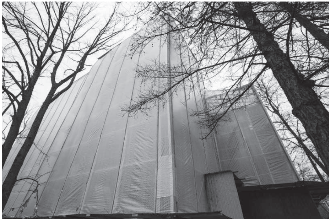
Рис. 15. Реставрация экстерьера Дацана. Фасады в лесах. 2014
