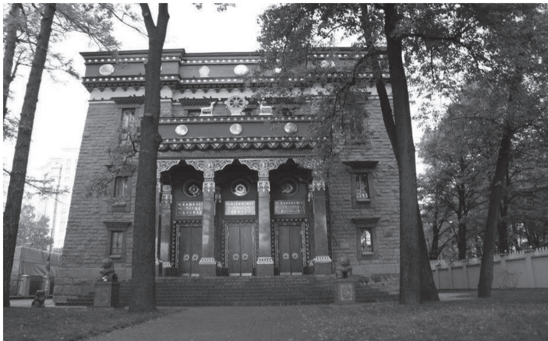
Рис. 16. Главный (южный) фасад. 2015
